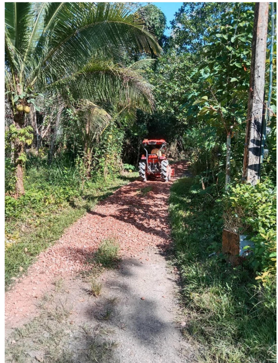
ซ่อมแซมถนนสายซอยในโหล หมู่ที่ ๕ กว้าง ๔.๐๐ เมตร ยาว ๓๐๐ เมตร
