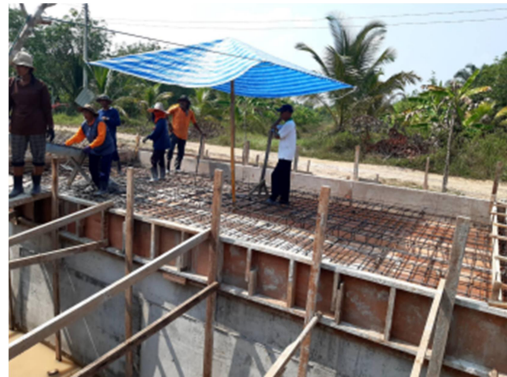
รูปกำลังดำเนินการก่อสร้าง
