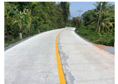
ดำเนินการก่อสร้างแล้วเสร็จ
